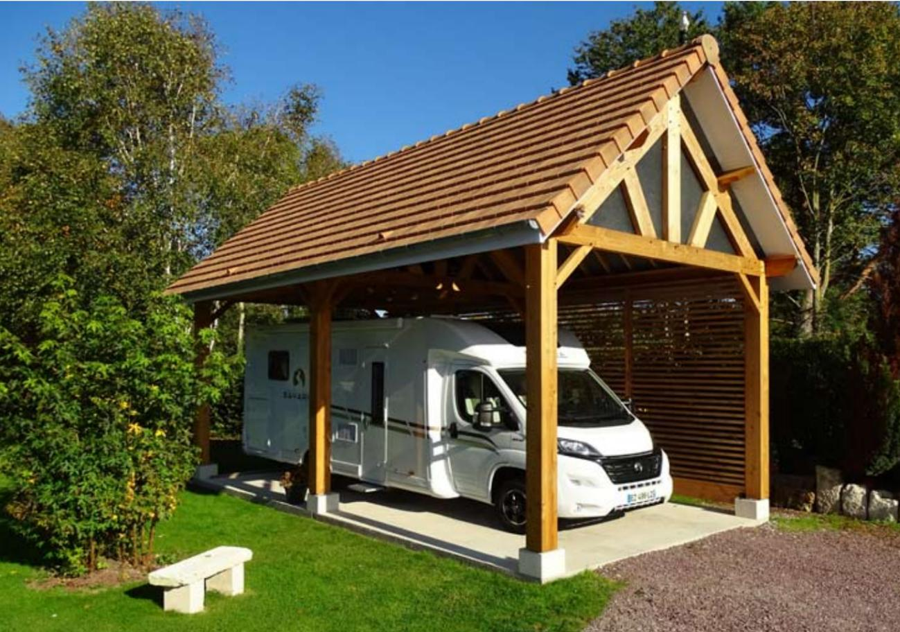
**Modèle 2 pentes** 3,50 x 7,50 m. Hauteur de passage 3,20 m. Couverture en tuiles mécaniques. 2 pentes 35°. Fermeture d'un côté par panneau brise vue lame horizontale.
