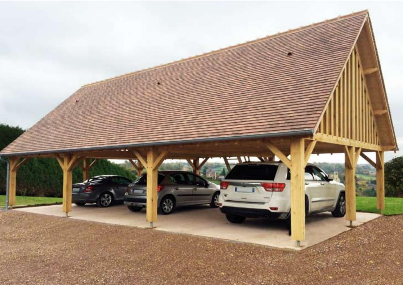
**Modèle 2 pentes** 6,00 x 12,00 m. Poteaux chêne 190/190 mm. Couverture en tuiles plates. 2 pentes de toiture 45°. Pignon en colombage.
